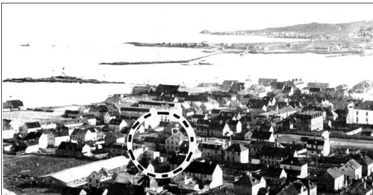
Au centre du cercle la 1ère école laïque construite en 1900
