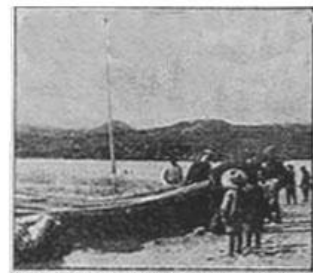
RENDU A TERRE, LE "WARY" EST AMARRÉ A UN CABLE FIXÉ A UN CABESTAN.
